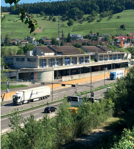
Teilabbruch des Gewerbehauses Gubrist.
