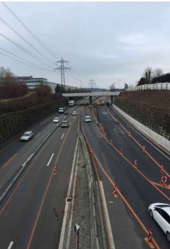
Die Instandsetzungsarbeiten an der Überführung Schaffhauserstrasse beim Stelzentunnel dauern von Mitte April bis voraussichtlich Mitte Dezember 2018.
