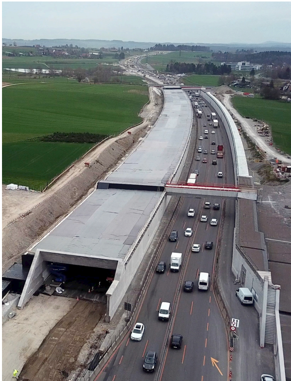
Die Bauarbeiten an der Überdeckung Katzensee in Richtung St.Gallen starten Anfang Oktober 2018 und dauern bis ca. Ende Jahr 2019.
