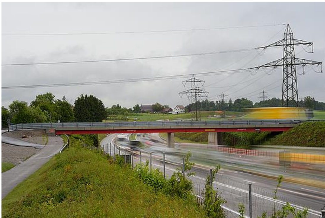
Hilfsbrücken erlauben die Verbreiterung des Trassees.
