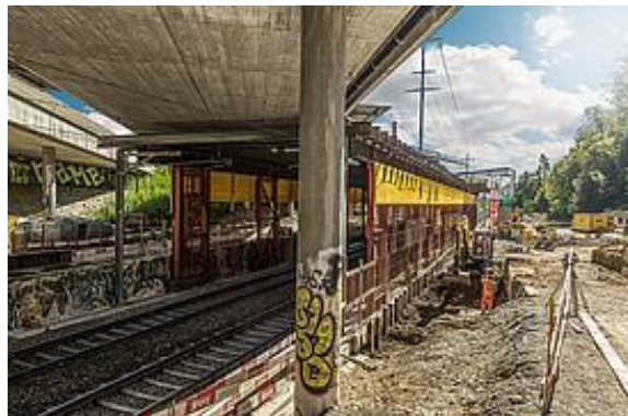
Beim Anschluss Zürich-Affoltern wurde ein Schutzschiene für die Bahnlinie Zürich-Affoltern-Regensdorf erstellt.
